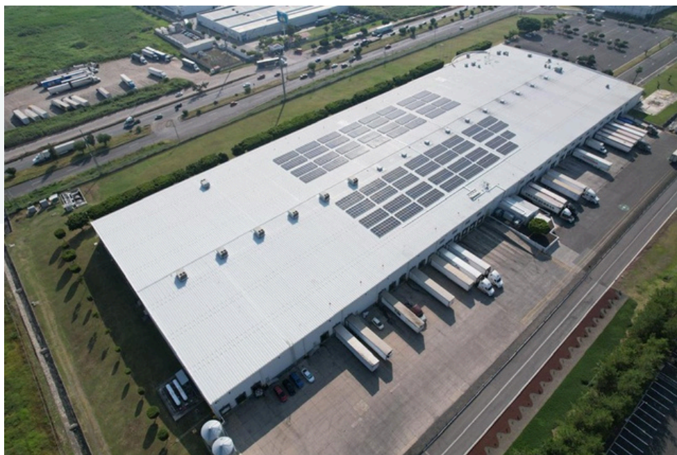
Installation de panneaux solaires à Guadalajara
